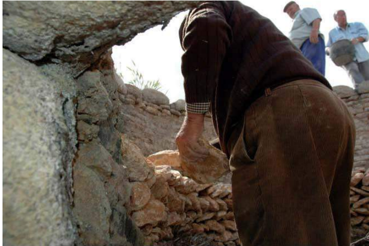
Foto 6.- Colocación de “armaeras”.
