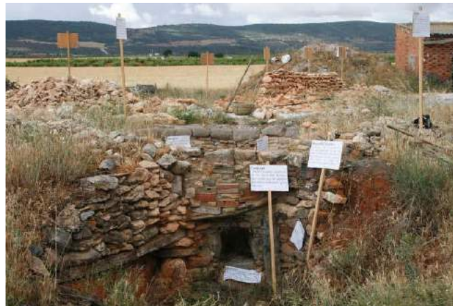
Foto 2.- Vista general de la calera de Orgaz.
