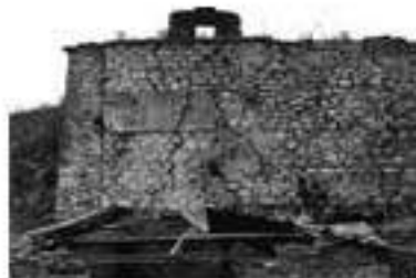
FRENTE CALERA LA PROVIDENCIA. ESTADO ACTUAL
