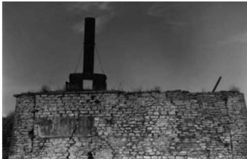
FRENTE CALERA, CARTEL CHIMENEA
